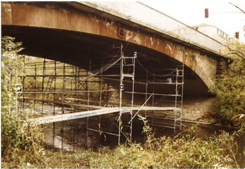
Bild 2. Ansicht der Schlachthofbrücke von Süden Fig. 2. The Schlachthofbrücke – view from south
